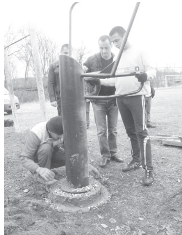
На снимке: Через несколько дней бетон затвердеет, и турник будет готов принять желающих потренироваться. Фото Валерия Широкопояса
